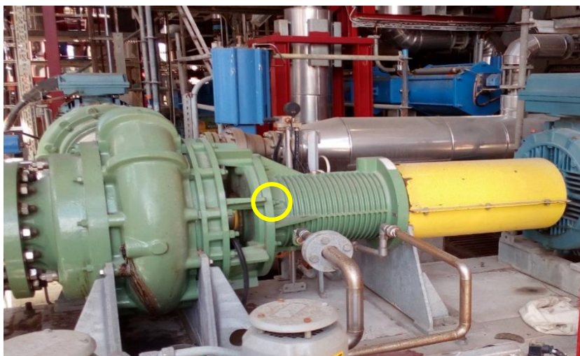
Figura 6.5 - Localização de parafuso desapertado
