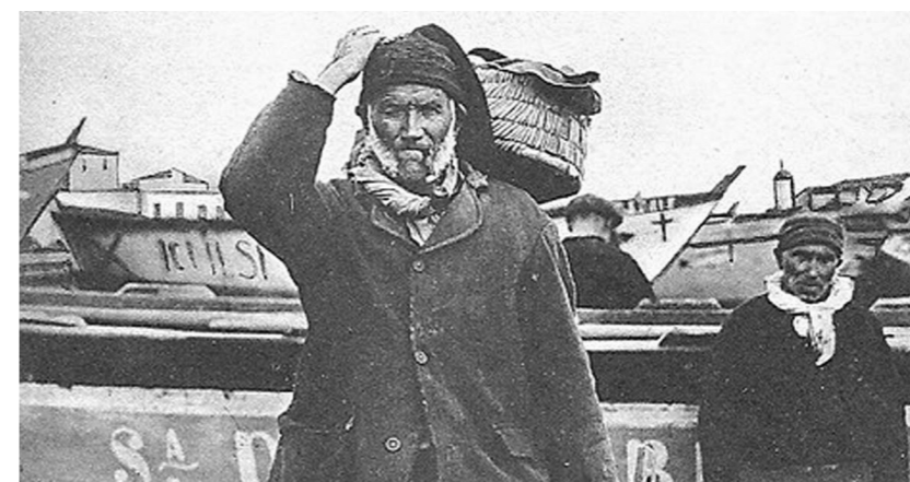
FIG.57 | O DESCARREGAMENTO DA 'CAÇA'
