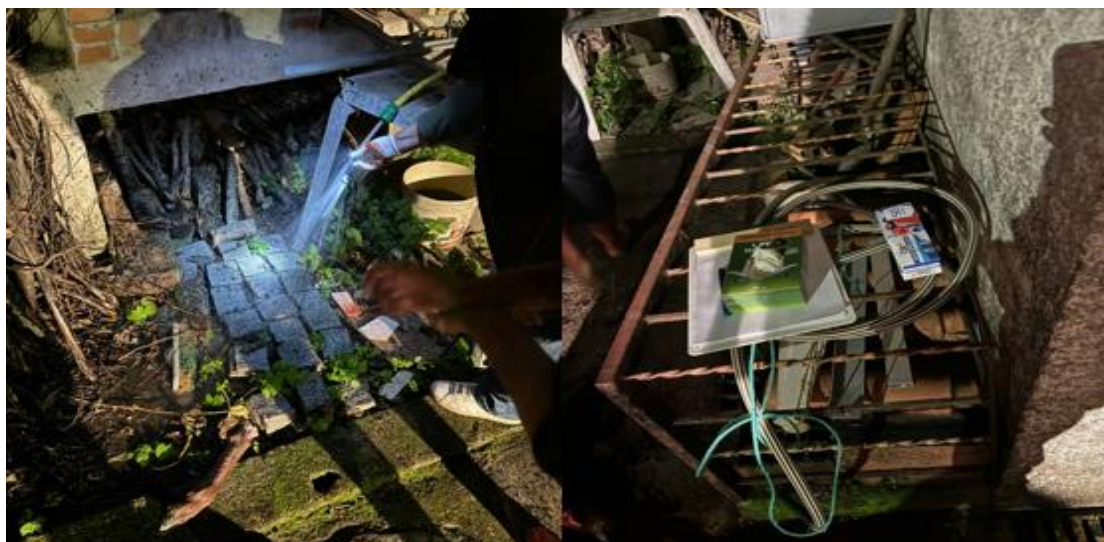
Figura 51 - Local pouco espaçoso, com condições reduzidas para a realização dos trabalhos e do exame inicial.
