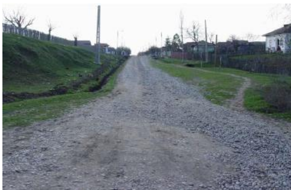
Figura 2.9: Estrada com desagregação. (MAI, 2005)
