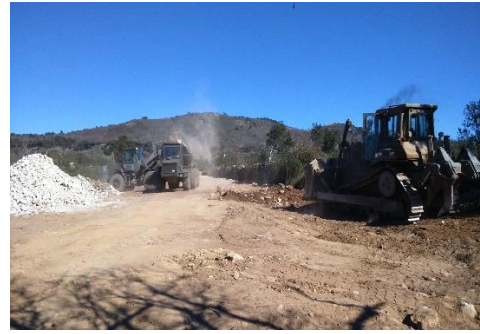
Figura 4.7: Trabalhos efetuados no terreno.
