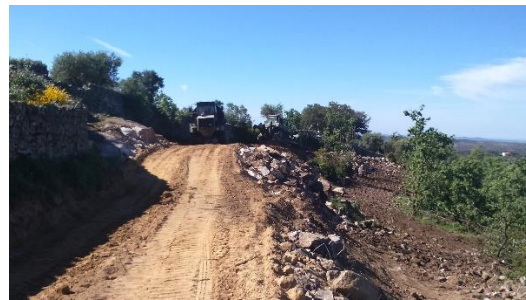
Figura 4.9: Construção da estrada.
