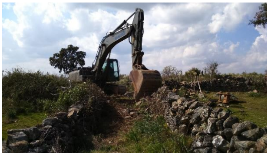
Figura 4.8: Muros de pedra existentes antes da intervenção do RE1.
