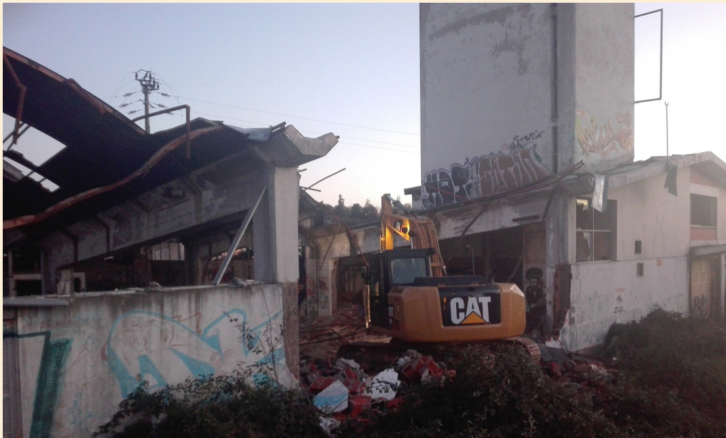
22 | Demolição da Panificadora de Vila Real, 2019
