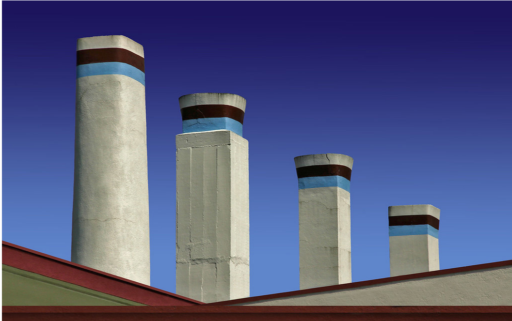
6 | Chaminés da Panificadora de Chaves, 2020
