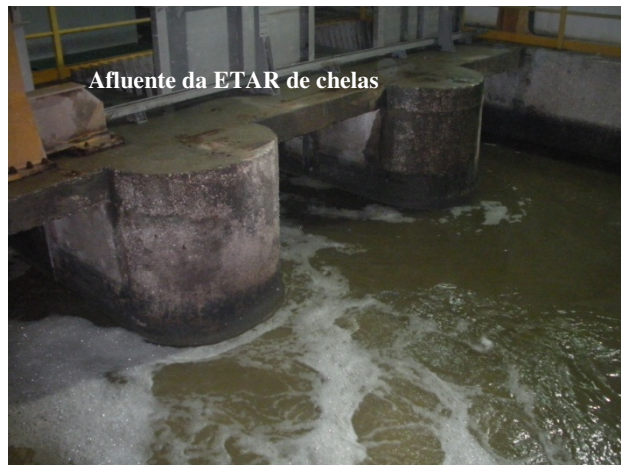
Figura 10: Entrada do afluente na ETAR de Chelas em Lisboa.
