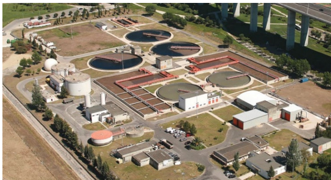
Figura 8: Vista aérea da ETAR de Beirolas localizada em Lisboa. Fonte: SimTejo disponível em http://editorial.up.pt/anexo/ficheiro/1/Normas de edicao.pdf .
