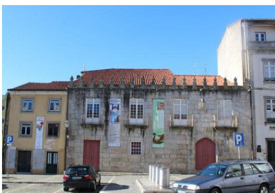
Fig. 202: Biblioteca Municipal, Largo José Novais, vista de este
