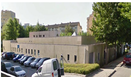
Fig. 160: Centro de Saúde-Avenida S. José, vista de oeste
