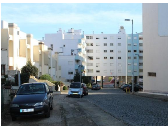
Fig. 152: Edifício multifamiliar de 10 pisos Rua Irmãos São João de Deus, vista de oeste
