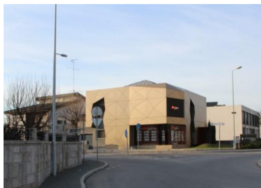
Fig. 208: Após a intervenção, vista de oeste
