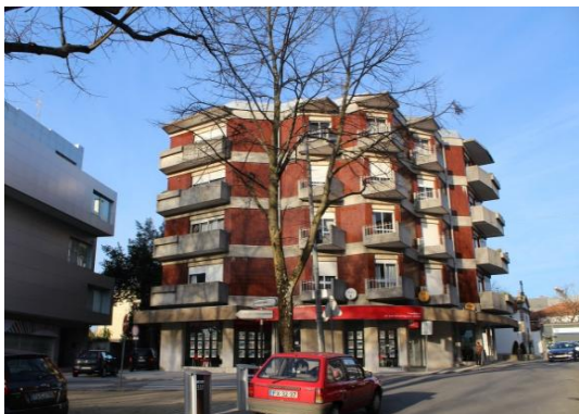
Fig. 150: Edifício multifamiliar de 5 pisos-Rua Tenente Valadim/Rua Candido dos Reis, vista de oeste
