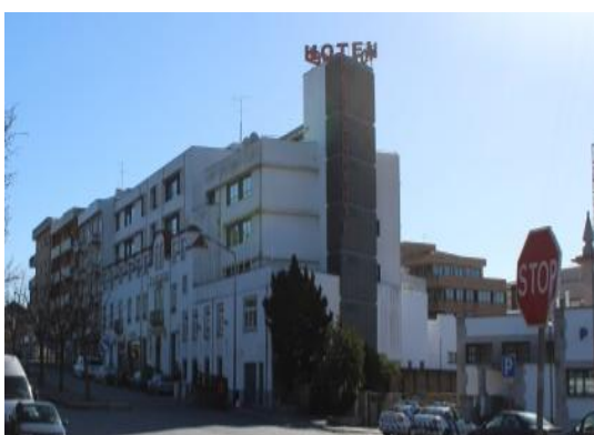
Fig. 215: Hotel Bagoeira-Avenida Dr. Sidónio Pais, vista de norte
