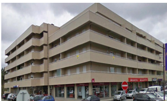
Fig. 194: Edifício de 5 pisos-Rua Celestino Costa, vista de sul
