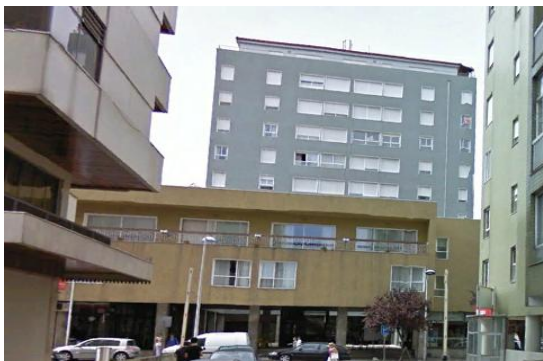
Fig. 164: Hotel Albergaria-Avenida Alcades de Faria, vista de sul
