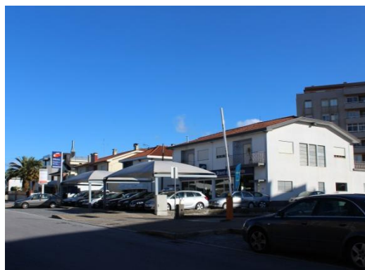
Fig. 135: Habitação unifamiliar individual de 2 pisos- Avenida Paulo Felisberto, vista de sul
