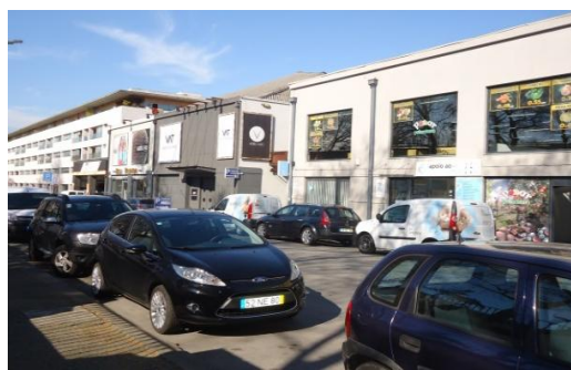
Fig. 210: Armazéns e discoteca-Rua Cândido Cunha, vista de este
