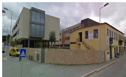
Fig. 195: Edifício de 3 e 2 pisos-Rua Celestino Costa, vista de Norte
