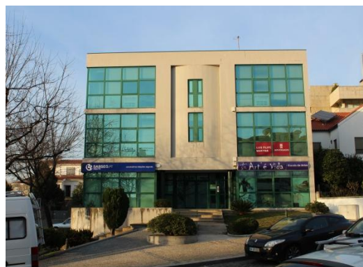
Fig. 206: Edifício destinado ao setor terciário 3 pisos-Rua José António Peixoto Pereira Machado, vista de sul
