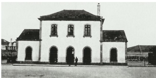
Fig. 39: Fotografia do edifício original
