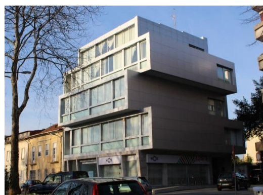
Fig. 193: Edifício multifamiliar/comercio de 5 pisos-Largo Camilo Castelo Branco/Rua Tenente Valadim, vista de oeste
