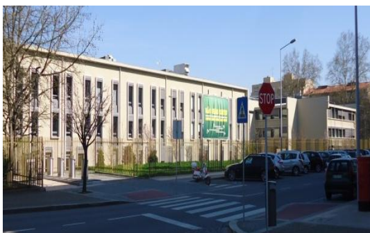
Fig. 219: Escola Secundária Alcaldes de Faria, vista de oeste
