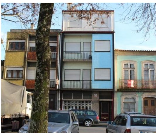
Fig. 148: Edifício de 4 pisos-Largo Camilo Castelo Branco, vista de Sul
