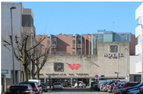
Fig. 213: Centro Comercial do Terço, Avenida dos Combatentes da Grande Guerra/Campo 5 de Outubro, vista de oeste
