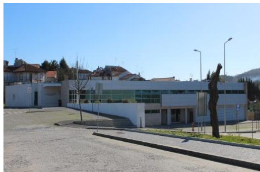
Fig. 222: Edifício de serviço paliativo e de fisioterapia- sem nome de rua, vista de oeste
