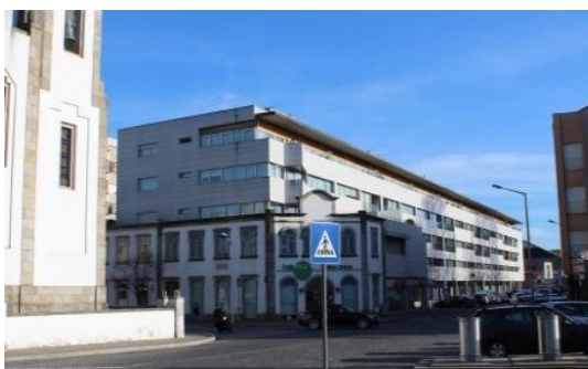
Fig. 209: Edifício multifamiliar-Rua Cândido da Cunha, vista de oeste
