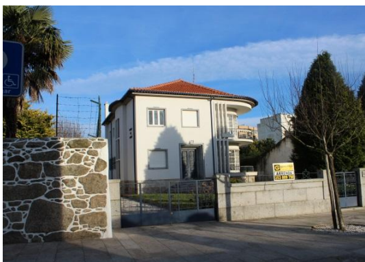
Fig. 132: Habitação unifamiliar individual de 2 pisos - Rua Dr. Manuel Pais, vista de oeste
