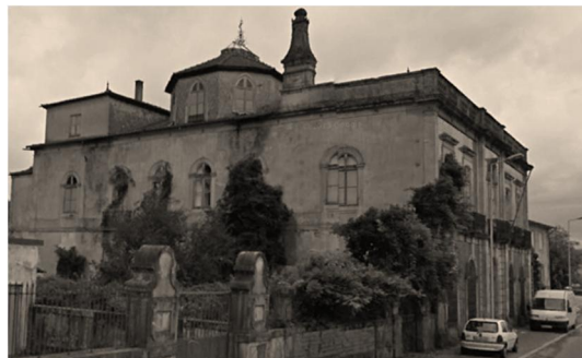
Fig. 159: Liceu, Rua Irmãos La Salle, vista de nor-nordeste
