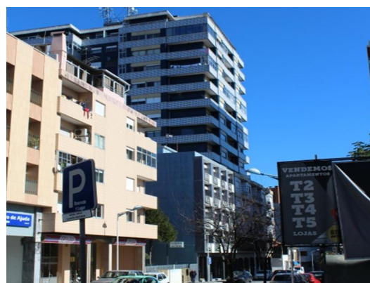
Fig. 153: Edifício multifamiliar/comercio 14 pisos-Avenida Alcades de Faria, vista de este/oeste
