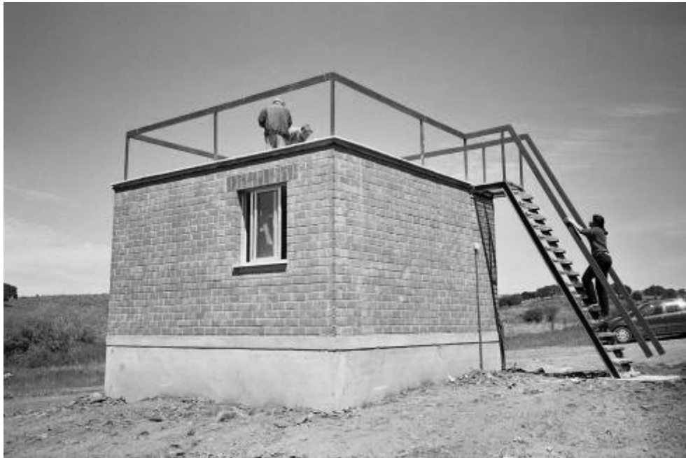
Figura 5. Fotografía del módulo terminado
