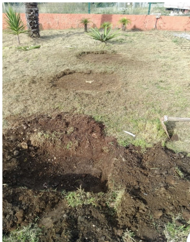
Fig. 50 - Excavación para la instalación del modelo A. Fuente: Fotografía del autor.
