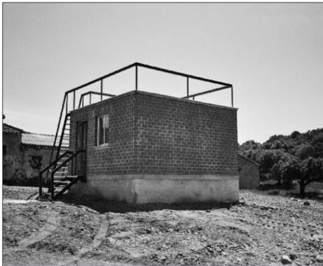
FIGURA 6 . Fotografía del módulo de vivienda donde se han probado los diferentes sistemas de protección frente a radón.
