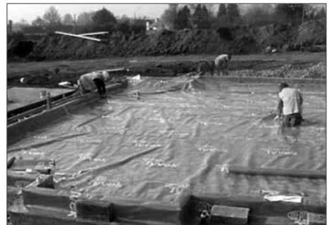
FIGURA 3. Barrera multicapa aplicada por bandas con solape. Marca comercial: DuPont Radon Plus Gas Barrier, DuPont Engineering Products.
