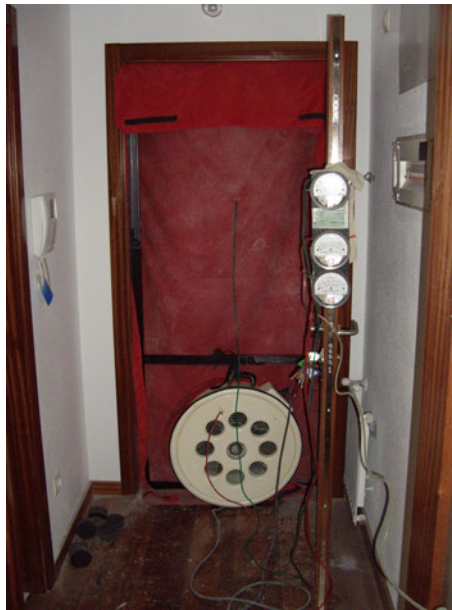
Figura 6.3: Foto de equipo puerta-ventilador.
