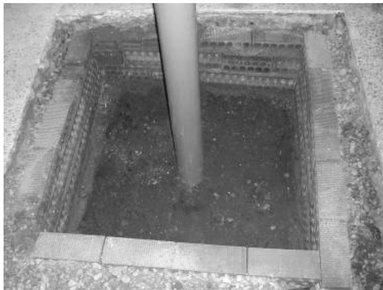
Figura 13. Fotografía de la construcción de la arqueta situada bajo la solera de sótano.
