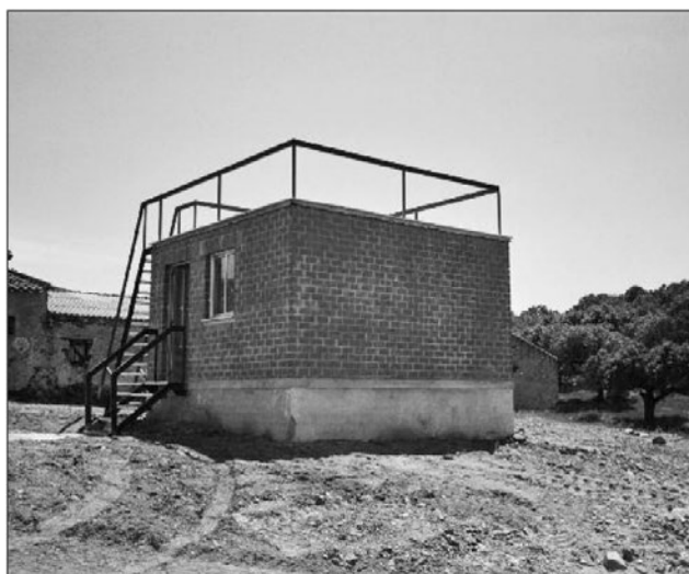
Fig. 41 - . Fotografía del módulo de vivienda donde se han probado los diferentes sistemas de protección frente a radón. Fuente: Borja frutos et al.(2011).
