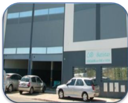
Figura 22: Instalações da BATISTAS SA no Prior Velho.
