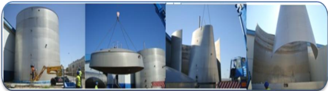
Figura 32: Desmantelamento da Central Lechera Asturiana.
