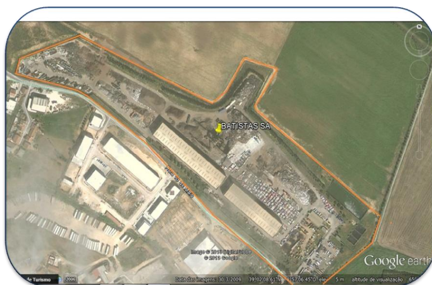
Figura 20: Instalações da BATISTAS SA no Carregado.
