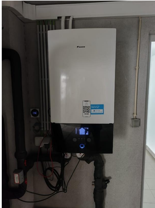
Figura 23 – Bomba de Calor Daikin EBBX16DF6V
