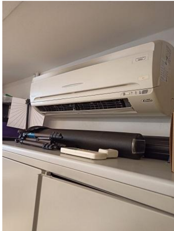
Figura 34 – Unidade Split , existente no laboratório AC.4
