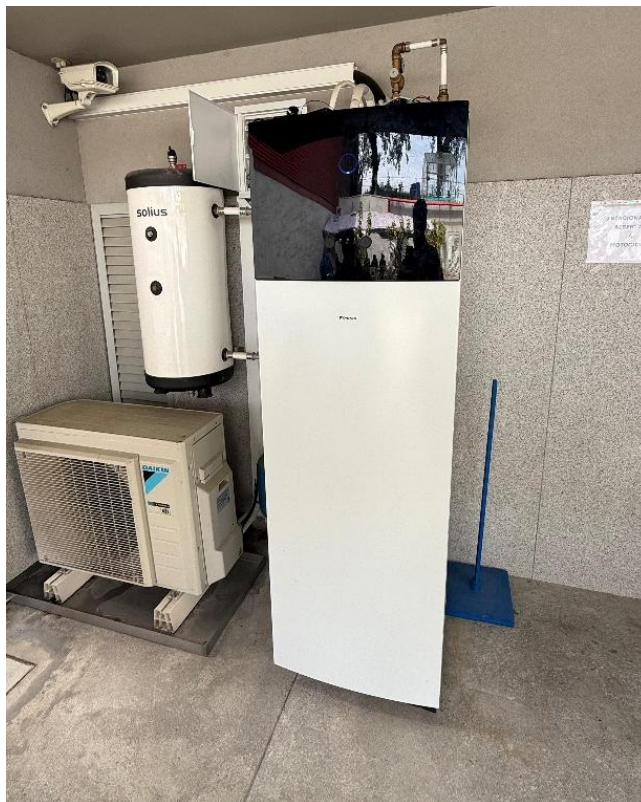
Figura 64 – Sistema de AQS Daikin Altherma 3 H HT W ETBH-E6V/E9W
