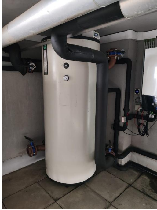
Figura 24 – Depósito de Inércia SICC Tech 218EXTRA1000
