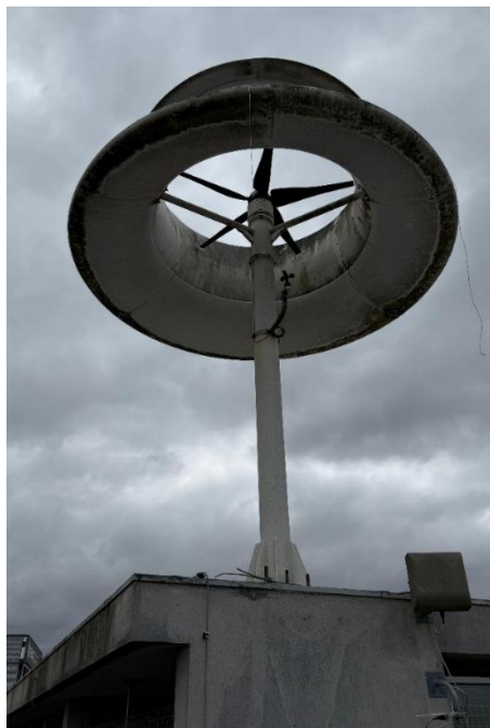
Figura 50 – Aerogerador de eixo vertical - desativado
