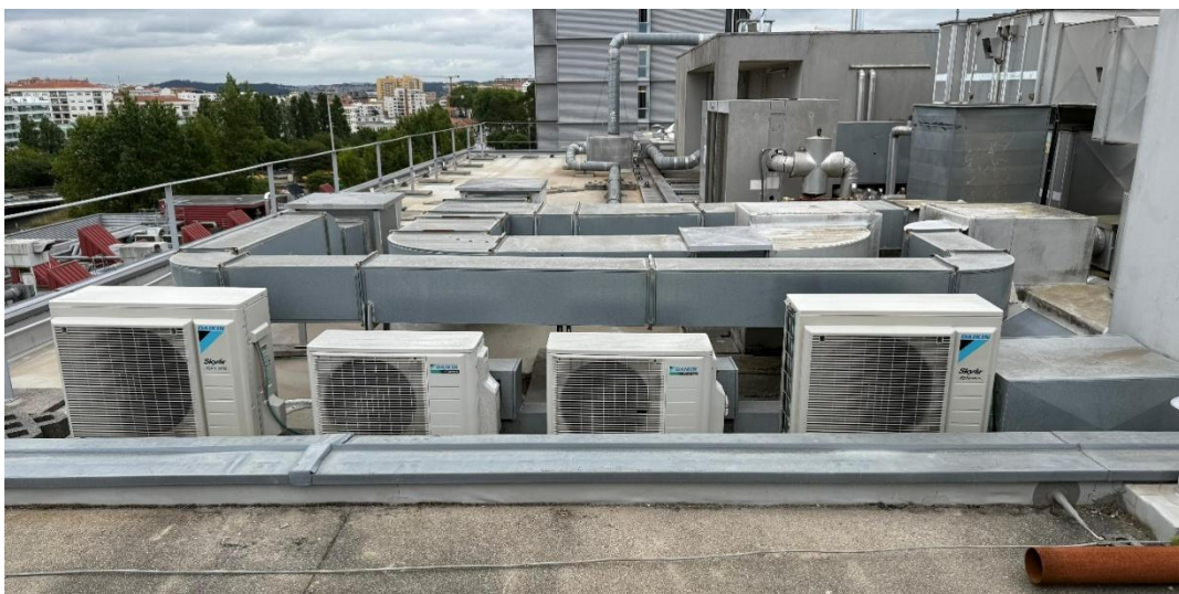
Figura 62 – Unidades exteriores dos sistemas de expansão direta, do INESC B
