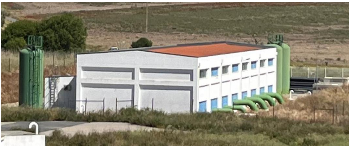
FIGURA 2 – ESTAÇÃO ELEVATÓRIA VISTA DO EXTERIOR
