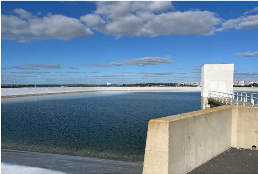
FIGURA 8 – RESERVATÓRIO DO CERRO
