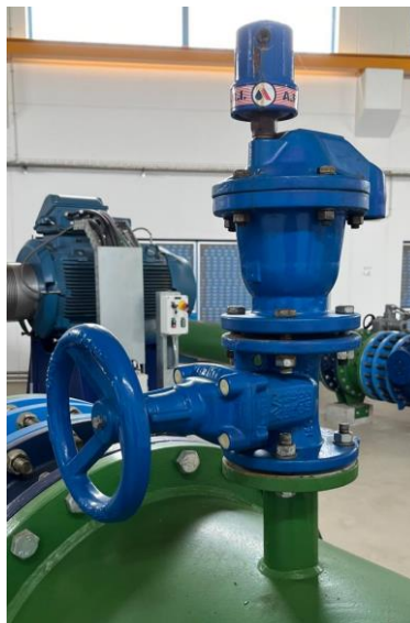
FIGURA 10 – VENTOSA DE TRIPLO EFEITO
