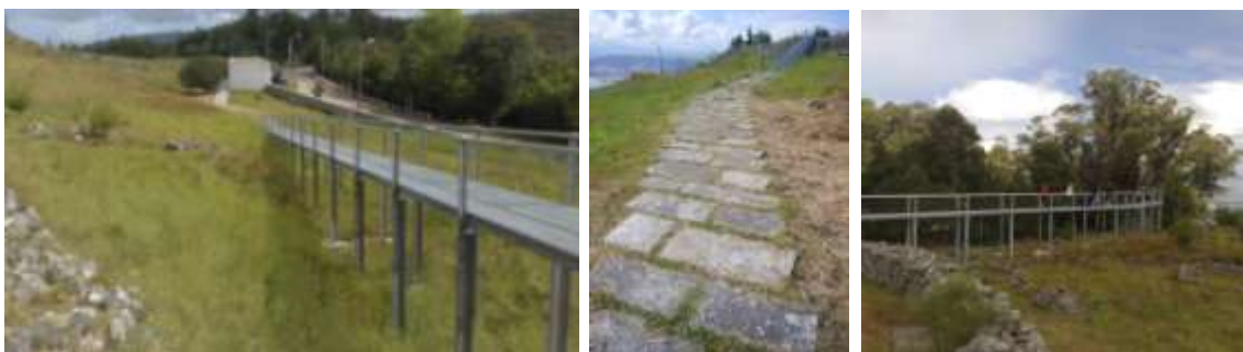
Fig. 101, 102 y 103 Rampas, pasarelas y pavimento de piedra
