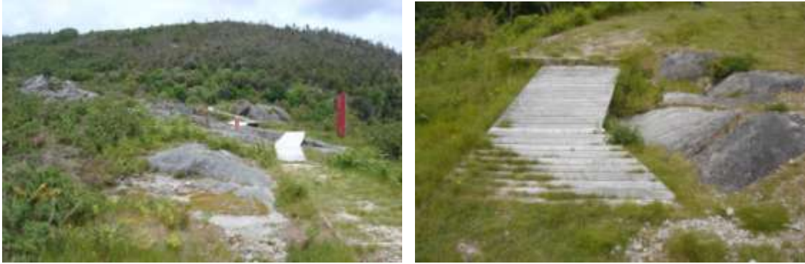
Fig. 130 y 131 Rampas que facilitan el acceso
