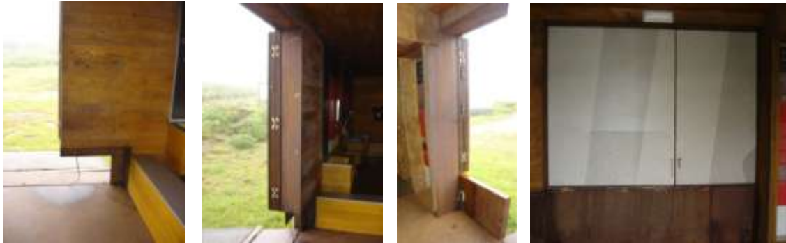
Fig. 137, 138, 139 y 140 Puerta de entrada
