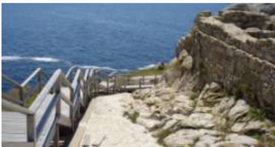
Fig. 161 Escaleras de acceso a la Batería
