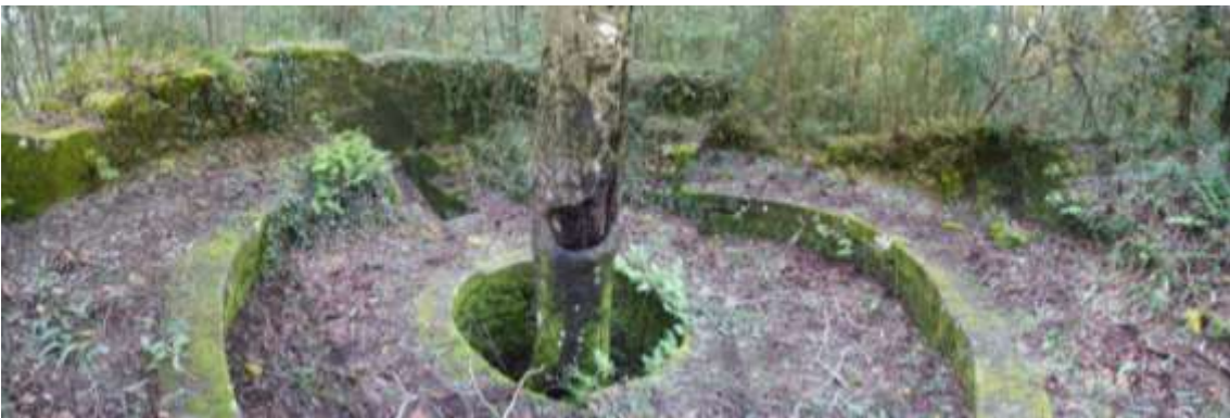
Fig. 31 Espacio central con la cisterna
