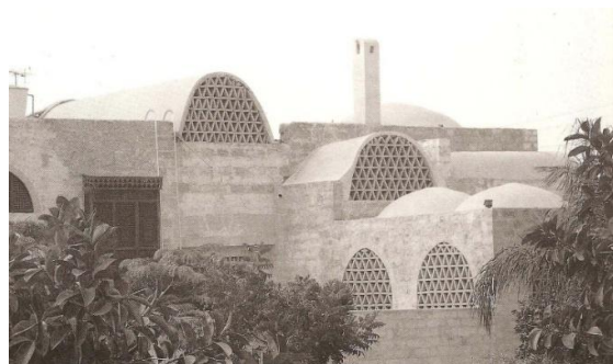
Fig. 149 - Vista desde el exterior a la cubierta
