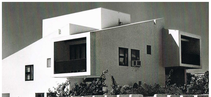
Fig. 152 - Vista desde el exterior hacia los voladizos
