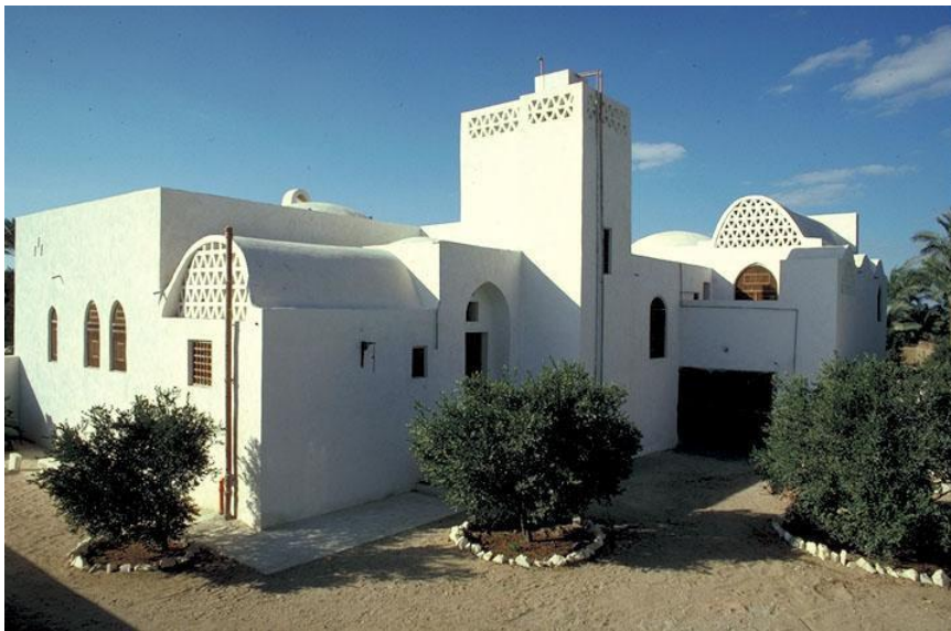
Fig. 43 – Vista exterior de la vivienda desde el acceso principal
