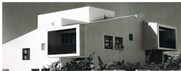
Fig. 63 – Vista desde el exterior
