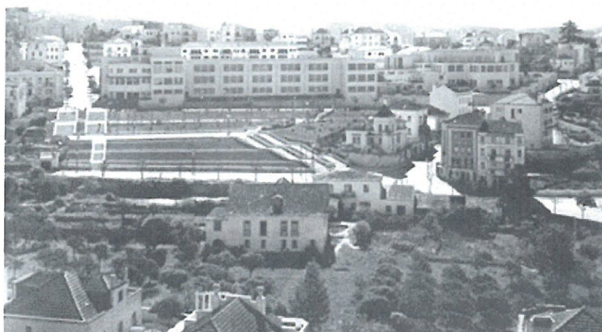
Figura II – Vista da Quinta da Rainha (Celas). Edifício da EMPC ao centro em baixo (Fotografia anónima, sem data. Imagoteca. Biblioteca Municipal de Coimbra)
