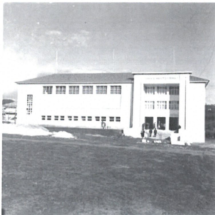
Figura III - Visita às obras da EMPC (Fotografia anónima. Imagoteca, Biblioteca Municipal de Coimbra).
