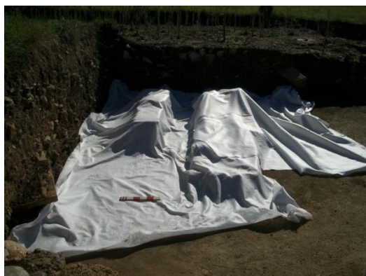
Fig. 5 – Proteção de estruturas [Doc.i)iv)20].
