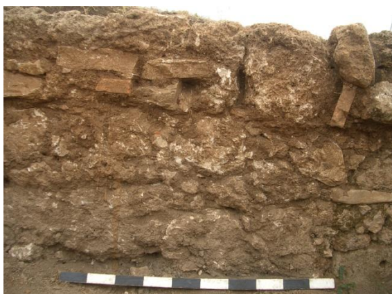
Fig. 4 – Aspecto da reconstrução (UE6) do muro da UE 11.
