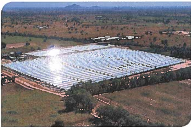
Figura 7 Heliostato de uma instalação com concentradores cilindro-parabólicos (Solarlite CSP Technology GmbH [CC BY 3.0 ( https://creativecommons.org/licenses/by/3.0/ )], via Wikimedia Commons).
