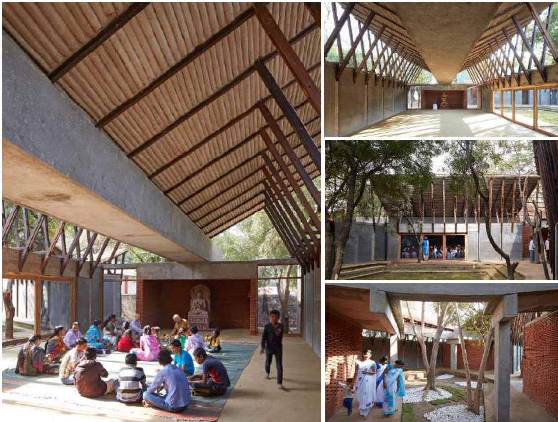
FIG 86 Y 87 - SALA PRINCIPAL, FIG. 88 Y 89 - PATIOS INTERIORES
