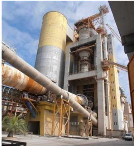
Figura 1.7 – Torre de ciclones.
