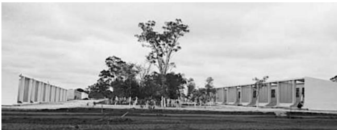
Figura 51 - Jardim década de 60. Fonte: Arquivo público do Distrito Federal
