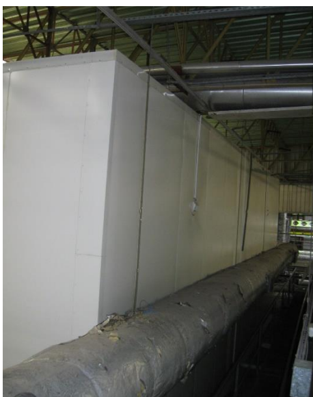
FIGURA 44 PARTE DO TÚNEL ACIMA DO TETO DA PRODUÇÃO
