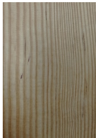
Figura 14 – Fotografia de pormenor da Trave central da obra “As Grades”;
