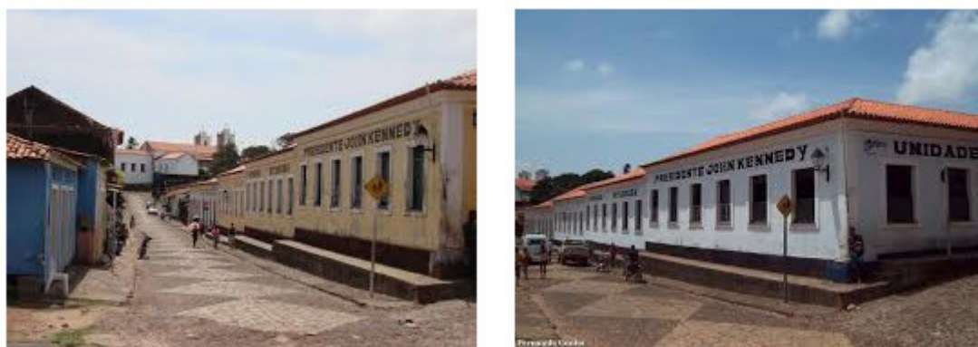
Figura 9 – Vista principal da Escola Municipal Unidade Integrada Presidente John Kennedy
