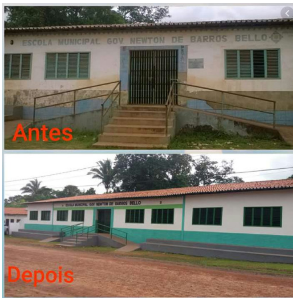
Figura 8. – Vista principal da Escola Municipal Governador Newton de Barros Bell, após sua reforma
