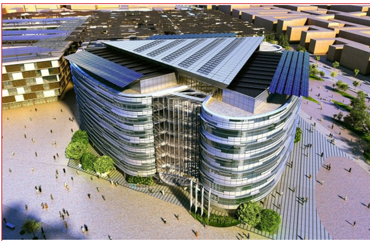
Fig.10: Agencia Internacional de Energía Renovable (IRENA HQ).
