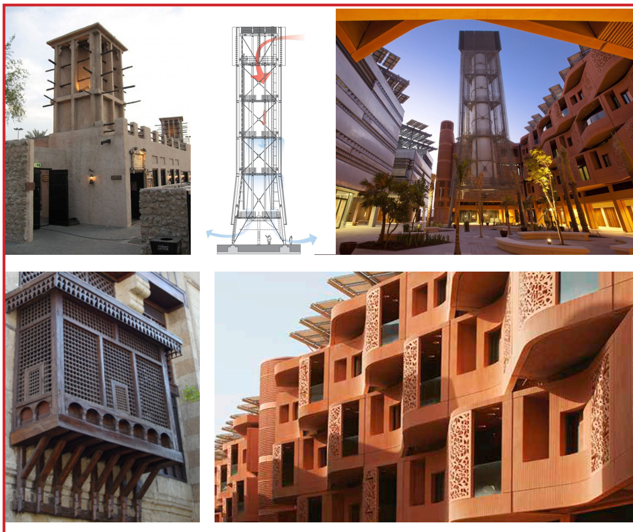
Fig.12: Tratamientos Vernáculos y Tecnología. Reinterpretación torre ventilación (arriba) y mashrabeyya (abajo).
