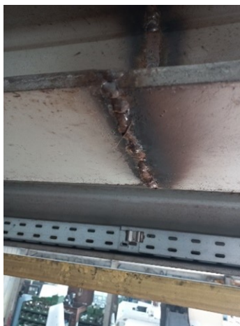
Figura 5.8: Soldadura de carril, Fonte: ISQ
