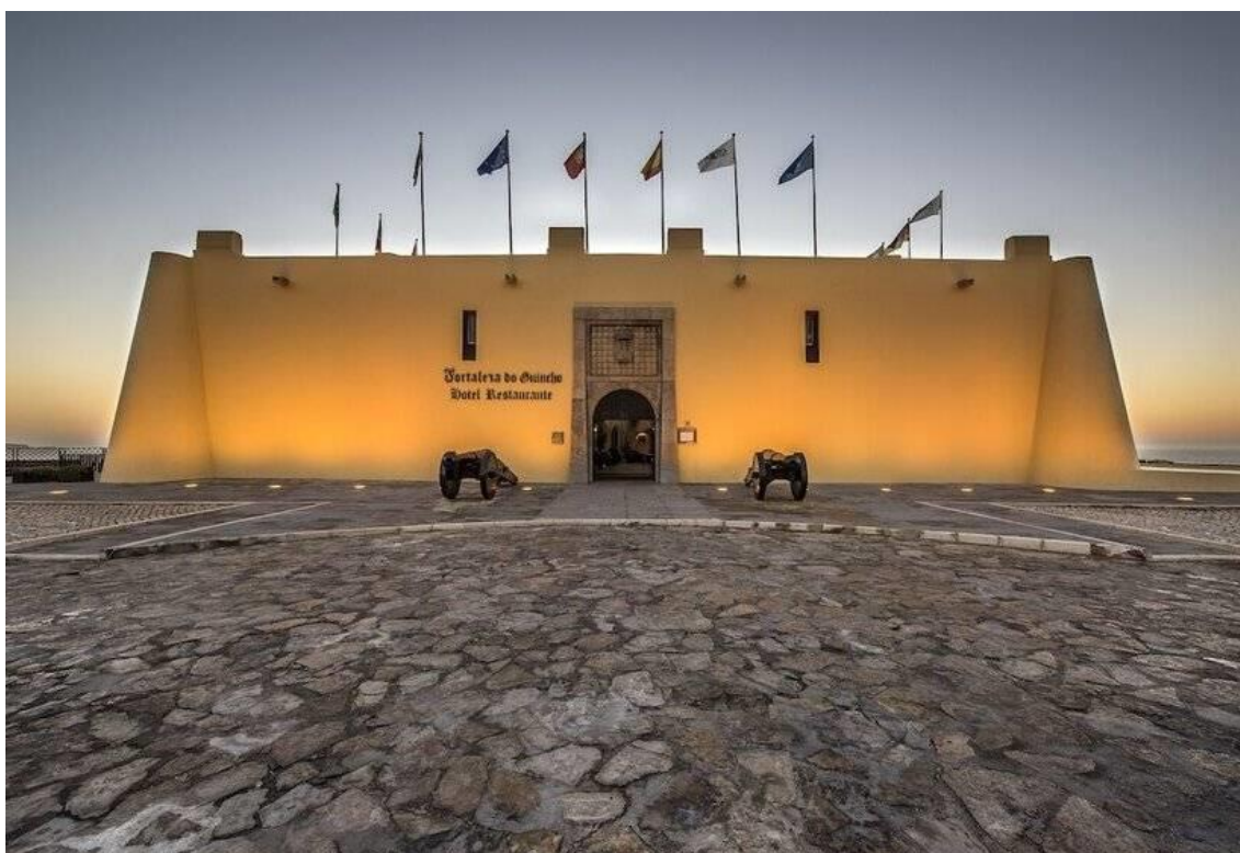
Figura 34- Fachada do Hotel Fortaleza do Guincho
