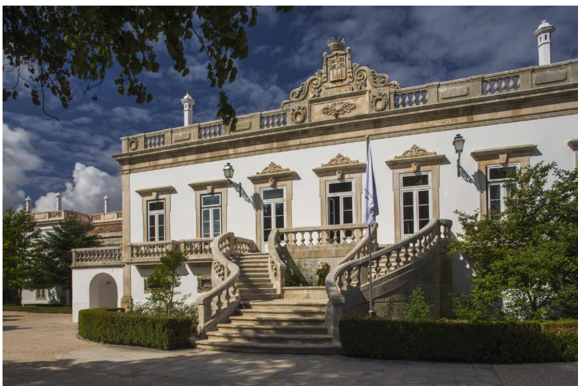
Figura 11. Fachada principal do Hotel Quinta das Lágrimas
