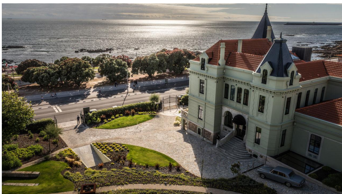
Figura 41- Vista lateral do edifício pré-existente, Vila Foz Hotel e Spa
