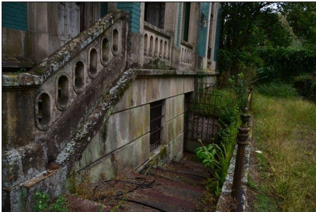
22. Escada principal de acesso à cave
