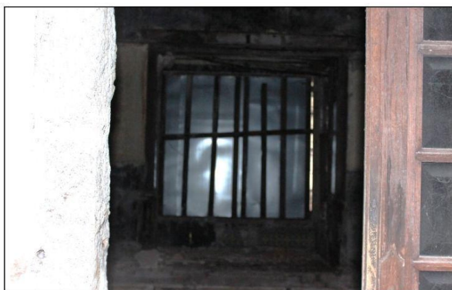
7. Pormenor da janela que dá para a varanda da sala de jantar
