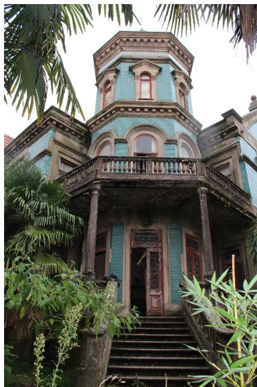
Figura 80- Torre, fotografia tirada no local
