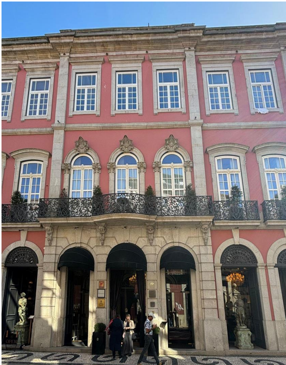
Figura 51- Fachada do hotel Torel Palace Porto
