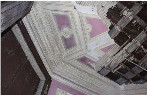
1. Fotografia de detalhes da pré existencia do teto do torreão;
