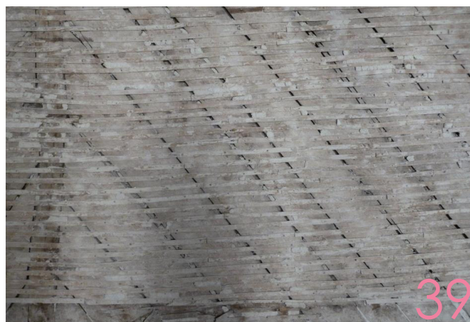
37 - Vigamento em pau-rolado; 38 - Estruturas de telhados; 39 - Tabique.
