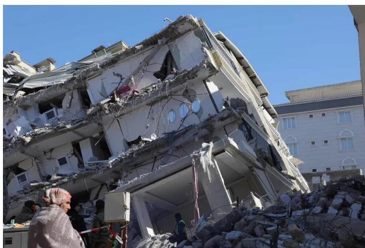
Figura 2 - Danos provocados pela ocorrência de um sismo na Turquia e na Síria [7]
