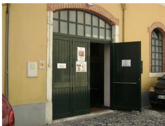
Figura 6 - Fachada principal da Casa da Achada
