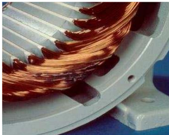
Figura 2. 32 - Aspecto visual dos enrolamentos do estator após um curto circuito entre espiras [39]
