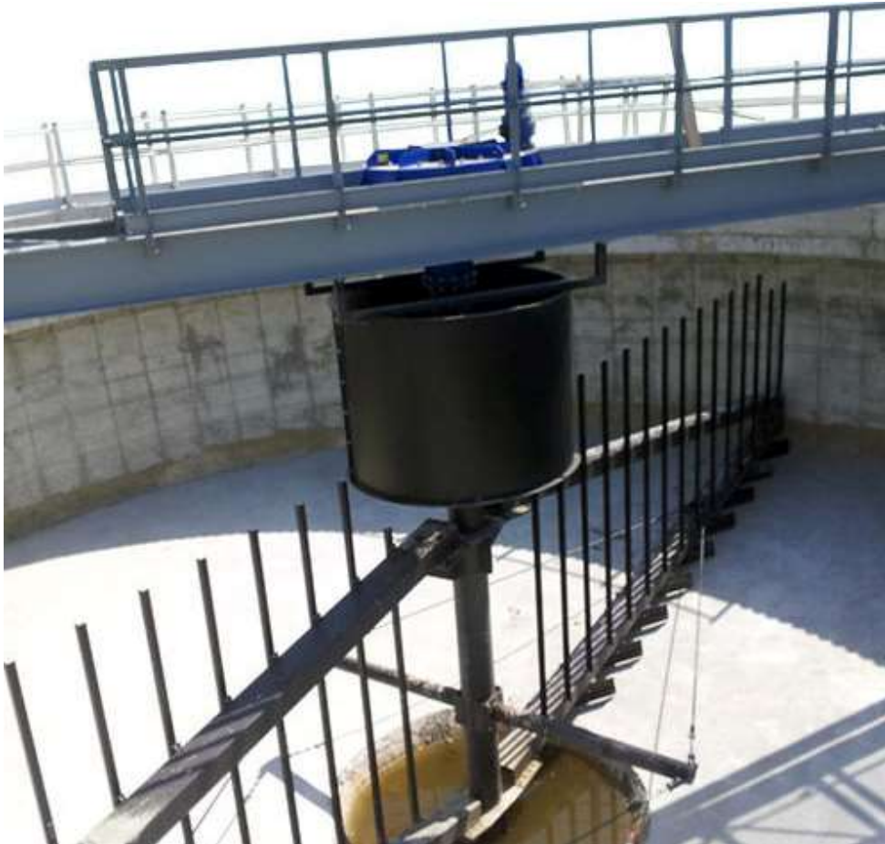
Figura 10. Espessador gravítico. Fonte: Google imagens (2023)
