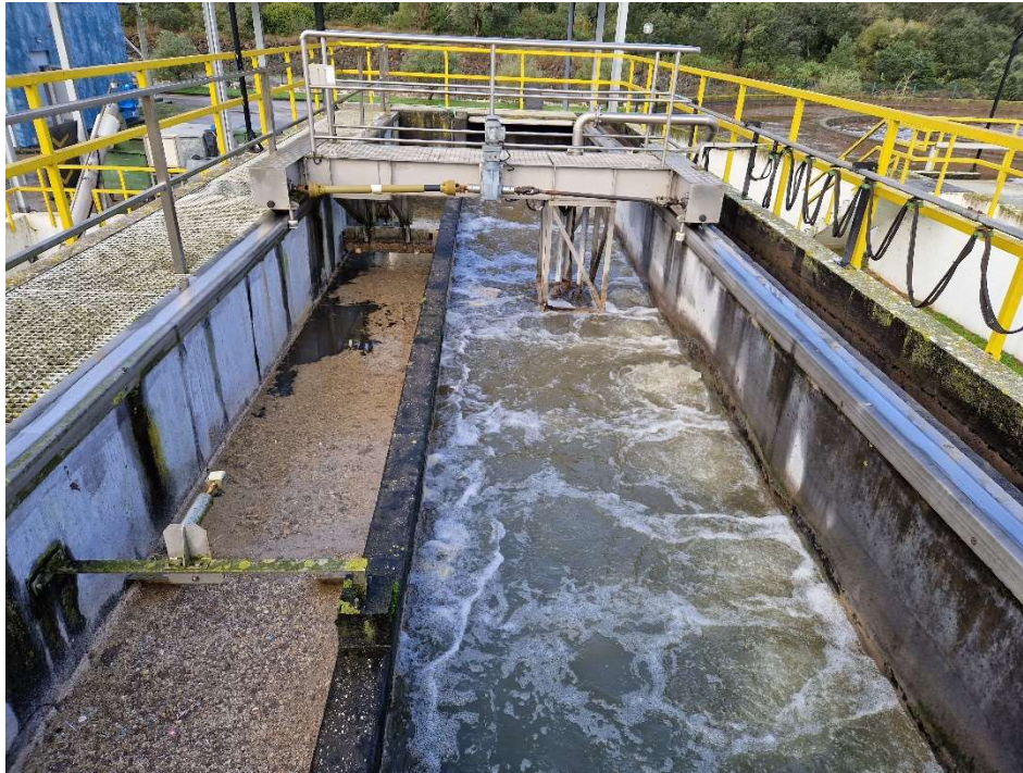
Figura 5. Desarenador e desengordurador (à esquerda), equipado com difusores de ar. Fonte: Carla Rodrigues (2023).
