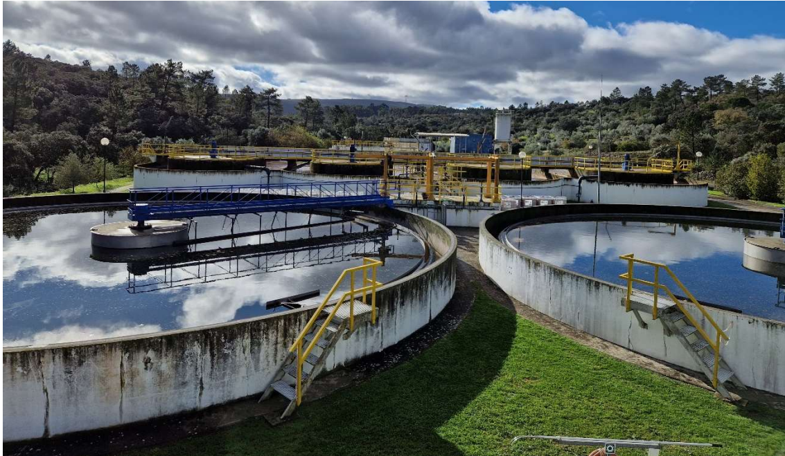
Figura 7. Decantador secundário. Fonte: Carla Rodrigues (2023)
