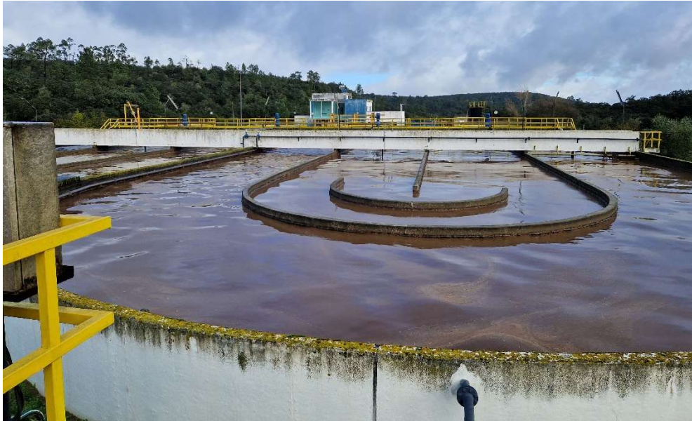
Figura 6. Reator biológico por sistema de lamas ativadas. Fonte: Carla Rodrigues (2023).
