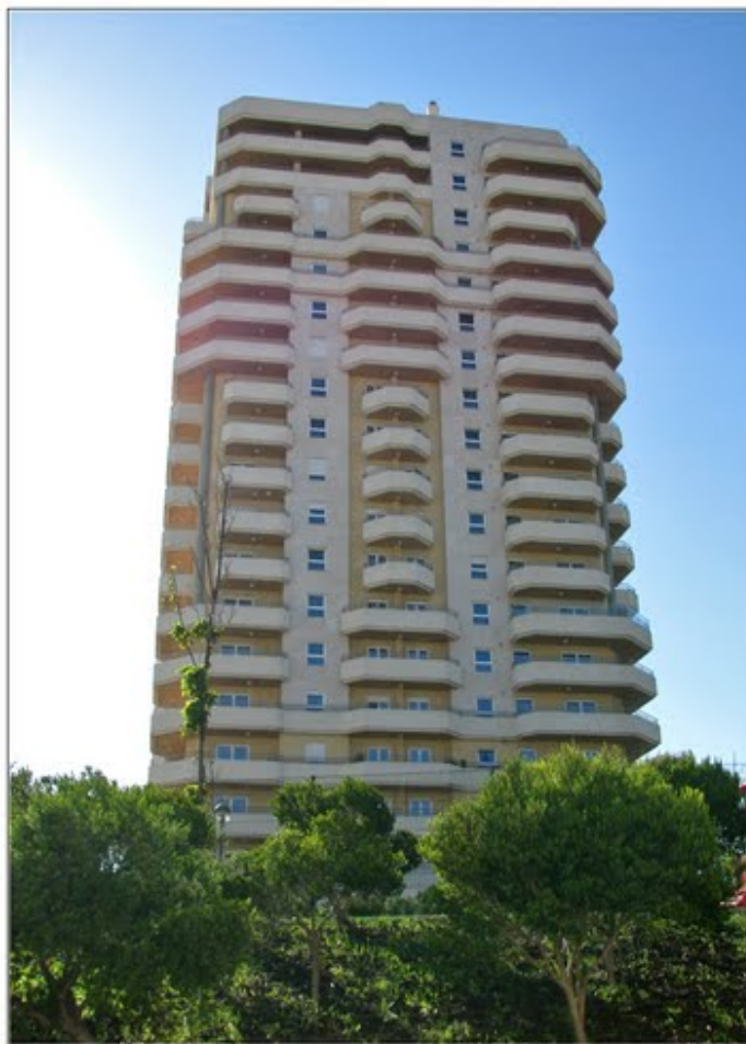
Figura 48 – Fotografia do edifício de habitação.
