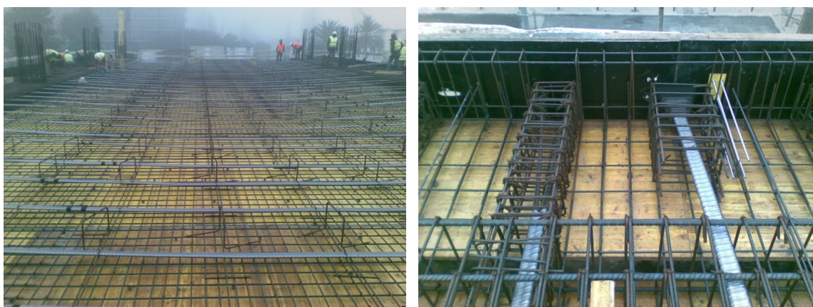
Figura 45 – Imagem da implantação dos cabos de pré-esforço. Ancoragens ativa e passiva.
