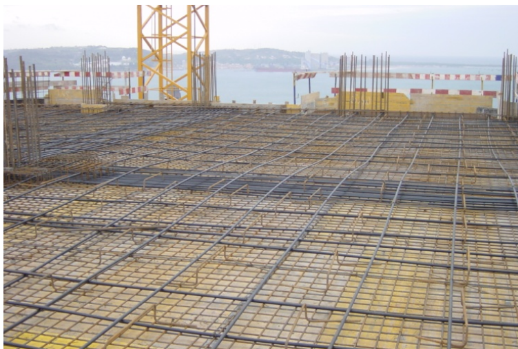
Figura 57 – Implantação dos cabos de pré-esforço.
