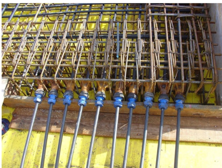
Figura 58 – Zona de reforça de ancoragens ativas.
