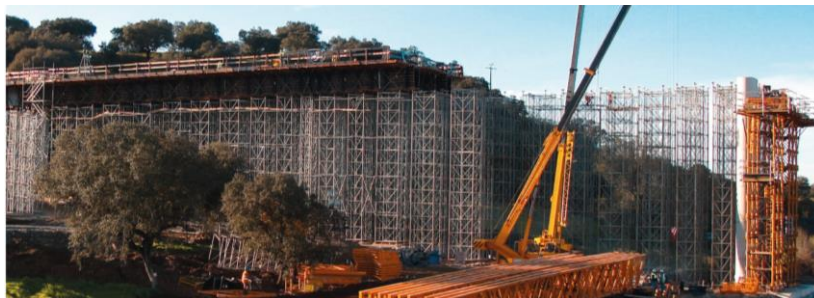
Figura 25 – Cimbre de sustentação de ponte
