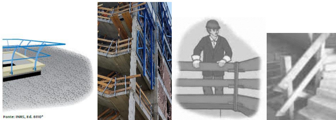
Figura 4 – Guarda-corpos, guardas metálicas e escudo de proteção
