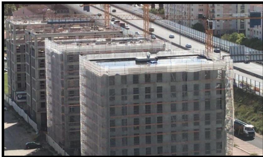
Figura 36 - Empreitada UHUB Lumiar em fase de execução
