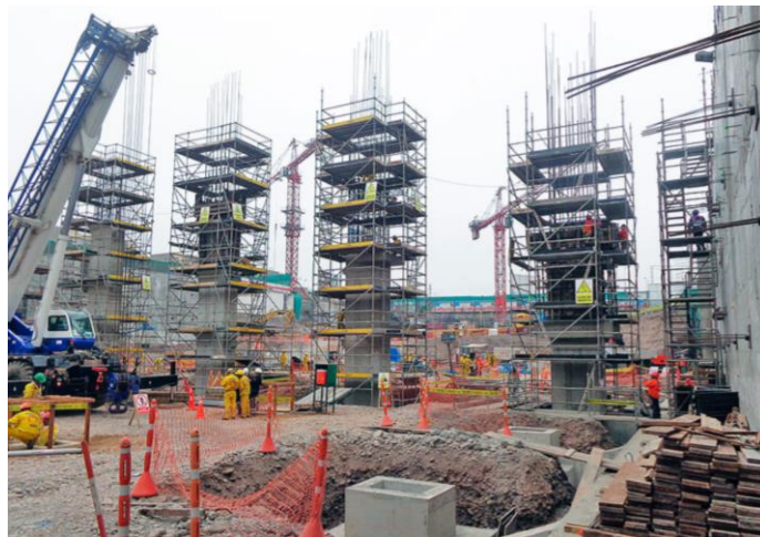
Figura 23 – Andaimes adequados para trabalhos em pilares
