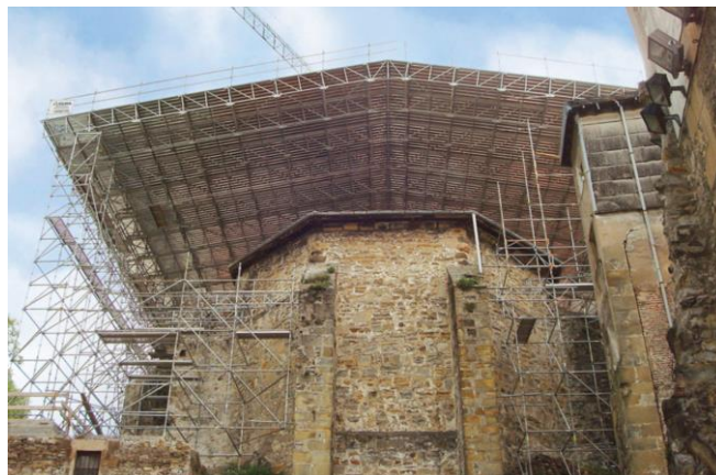
Figura 24 – Andaimes de conservação de cobertura
