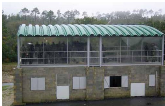
Figura n.º 10 - Edifício Laboratório
