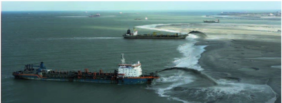
Figura 1 – Rainbowing: projetar areia pela proa para recuperação da praia. (Bray & Cohen, 2010, p. 10)
