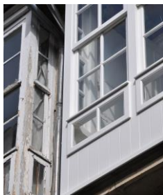
34. Imágenes del Estado Actual Fachada / Galería / Detalle Carpintería
