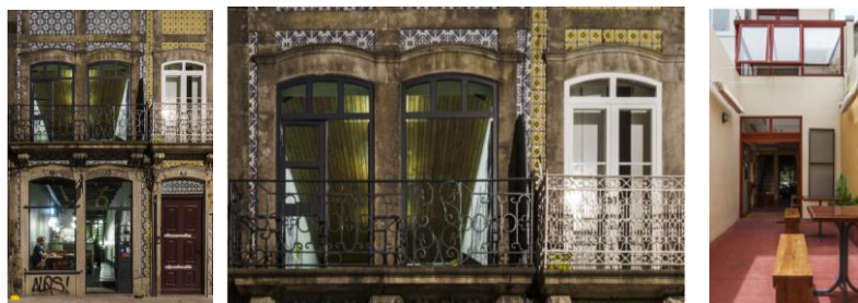
13. Imágenes del Estado Actual Fachada
