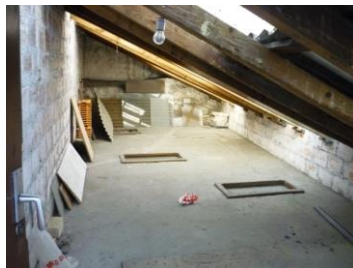
12. Imágenes del Estado Actual Cubierta
