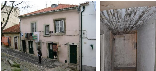
17. Imágenes del Estado Previo Cubierta/ Lucernario / Bajo Cubierta
