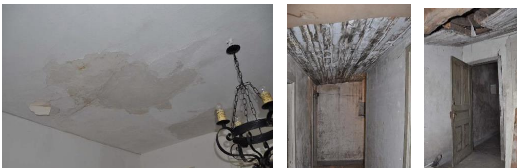
25. Imágenes del Estado Previo Sistema Estructural
