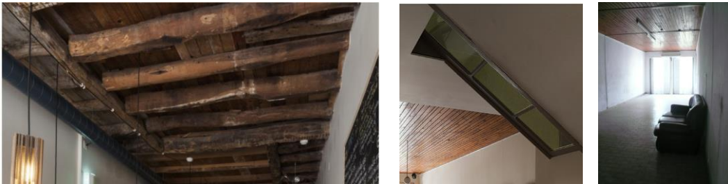
10. Imágenes del Estado Actual Sistema Estructural
