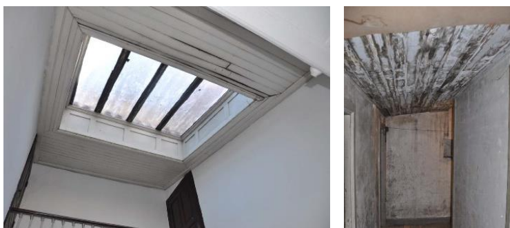
27. Imágenes del Estado Previo Cubierta / Lucernario
