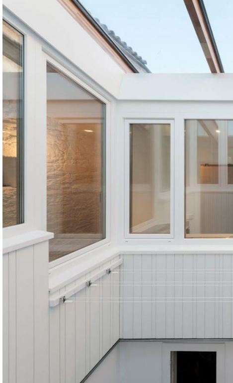
24. Estado Reformado Patio Interior
