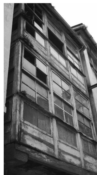
64. Fachada y Galería Calle Rúa Benito Vicetto del Edificio 29.
