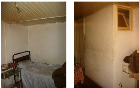
15. Imágenes Estado Previo Sistema Estructural
