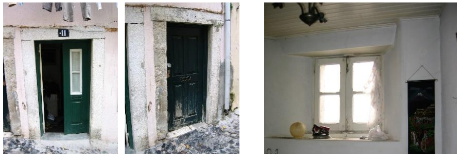
18. Imágenes del Estado Previo Fachada / Detalle Carpintería
