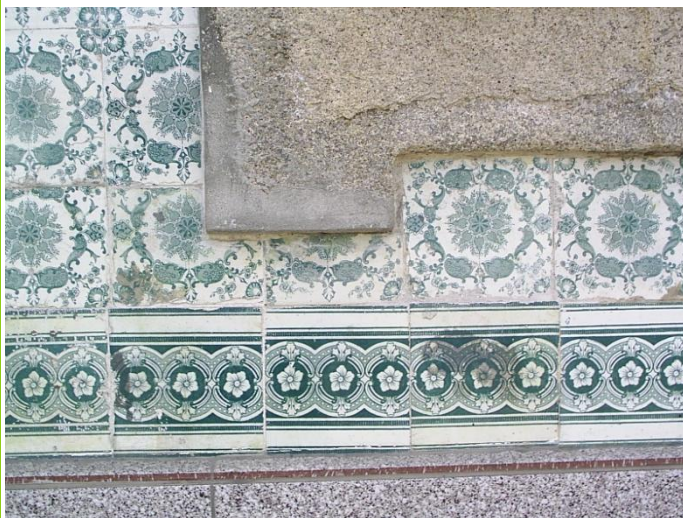
Degradação do granito, e microrganismos no interface vidro-chacota
