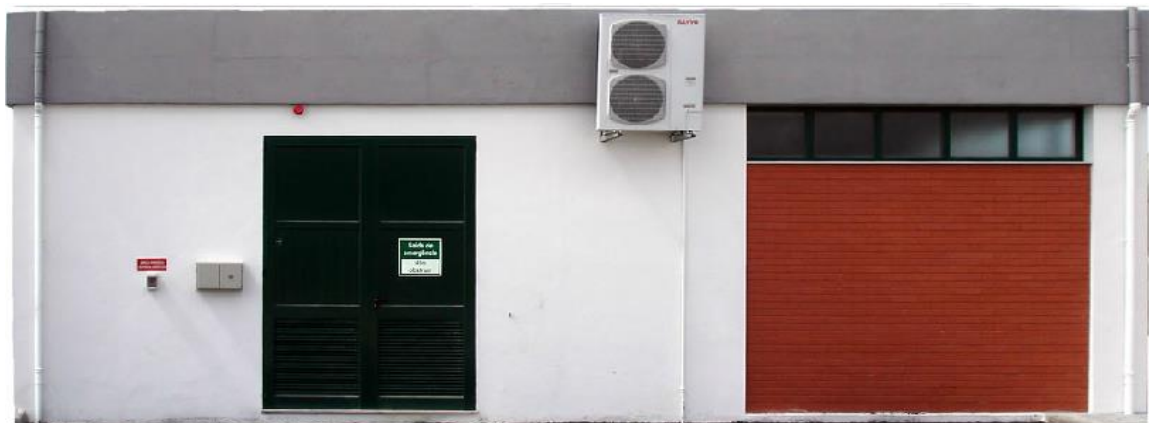
Figura 3.14 - Edifício de Comando.
