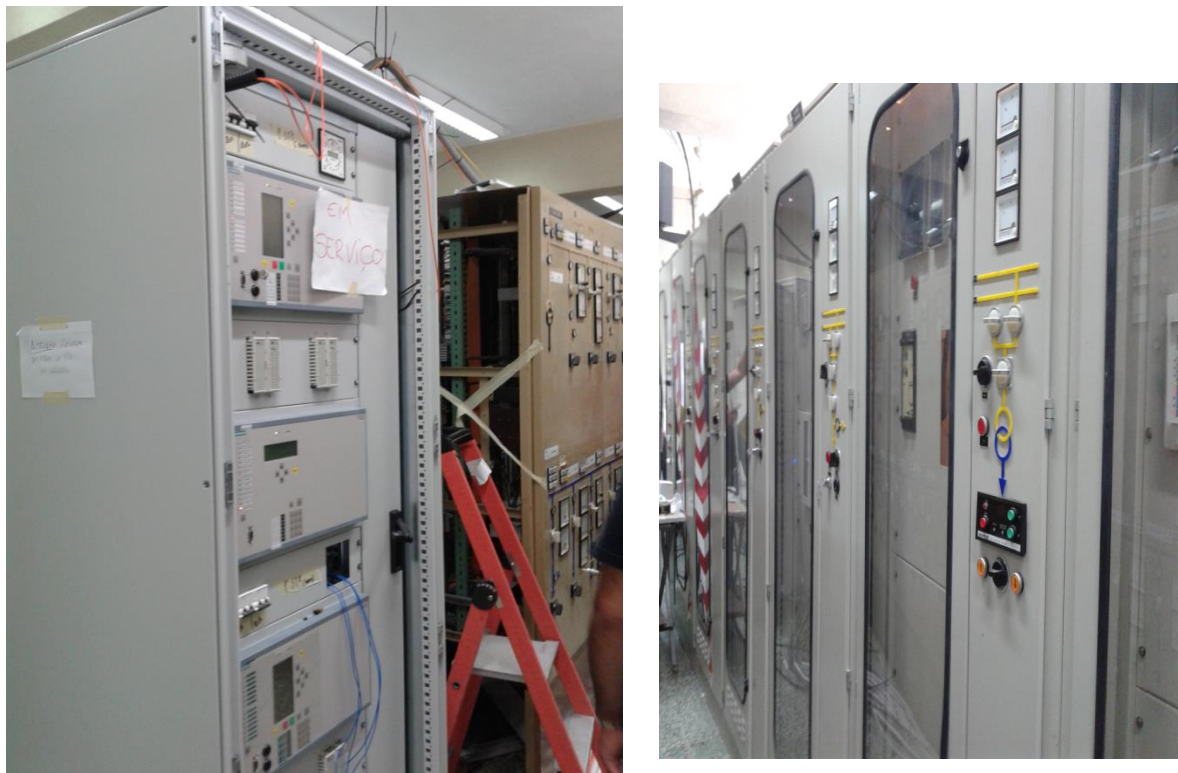
Figura 4.8 – Remodelação do Sistema de Proteção, Comando e Controlo.
