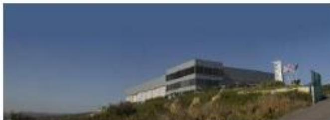
Figura 1.1 – Instalações da RENASCIMENTO de Loures.
