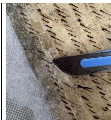
Figura 153: Remoção de fixação
