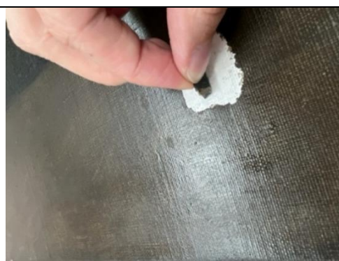
Figura 70: Nivelamento com lixa
