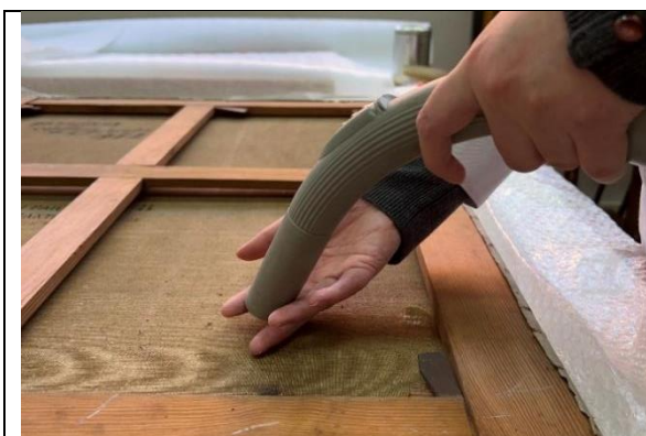
Figura 53: Uso do aspirador na remoção de sujidade
