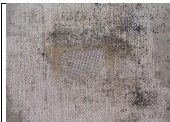
Figura 113: Reforço da área tratada
