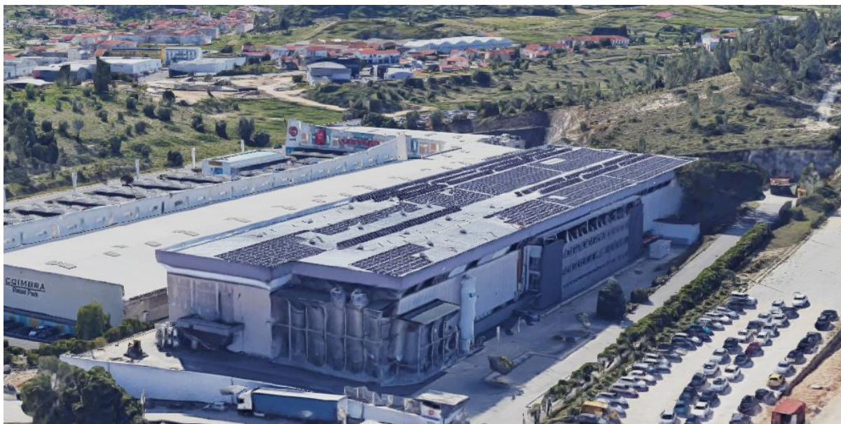
Figura 3-4 – Vista aérea da Fábrica Dan Cake Coimbra 5
