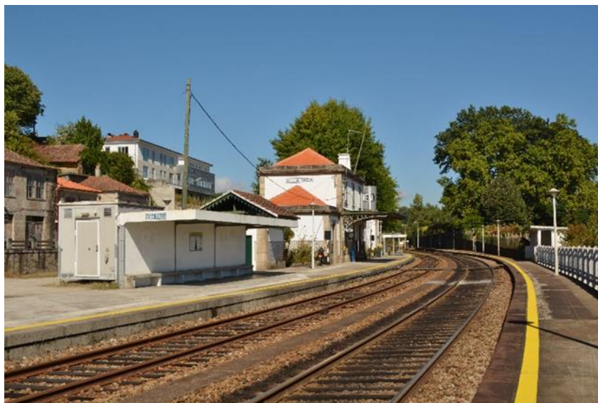
Figura 3.9 – Vista sul da estação de Vila Meã (Santos, 2015)
