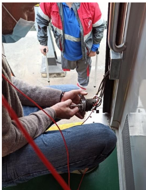
Figura 4.26 – Ligação ao comutador de serviço concluído
