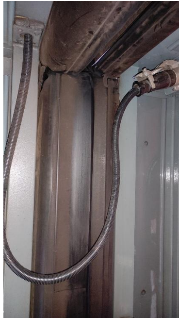
Figura 4.15 – Acoplamento das tomadas UIC 558 entre carruagens
