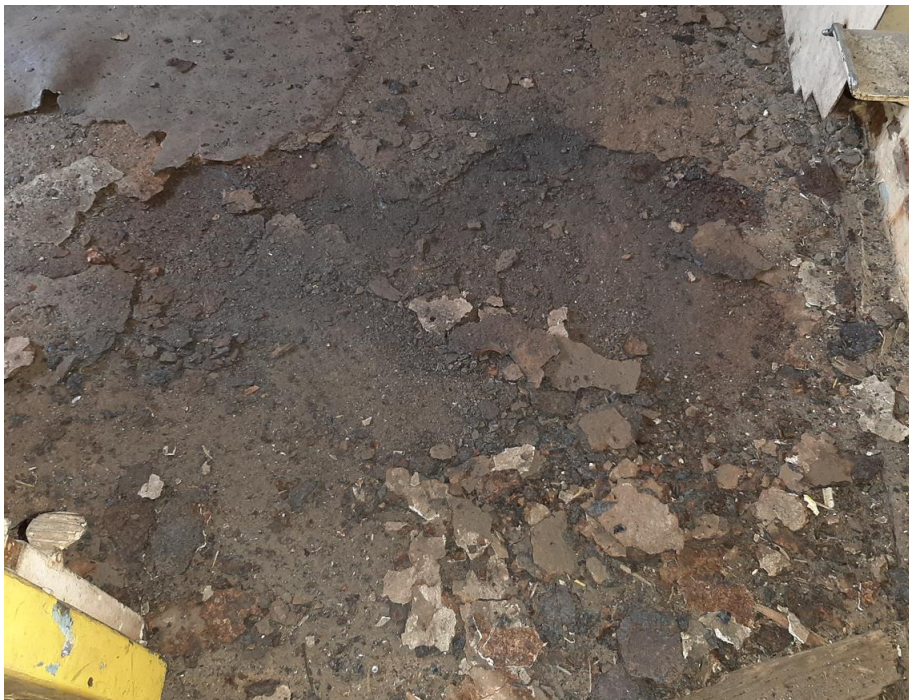
Figura 46 - Chão da cabine de condução antes da substituição.
