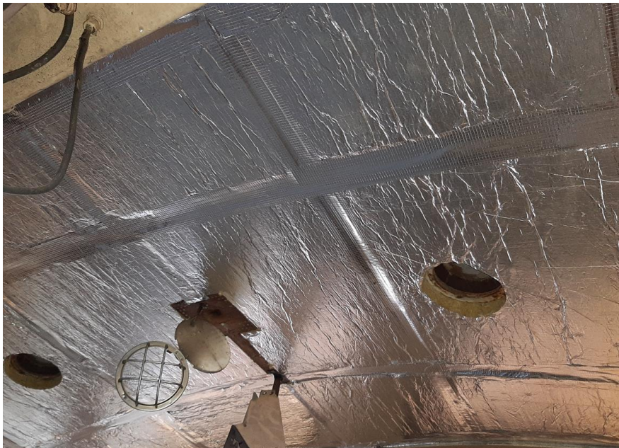
Figura 44 - Isolamento da cabine.
