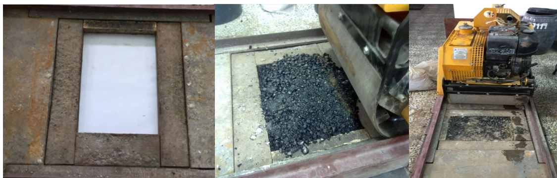
Figura 3.16 Processo de compactação das lajetas
