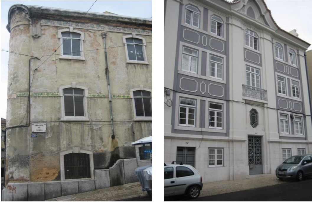
Figura 8 - Estados de conservação dos edifícios em Alcântara
