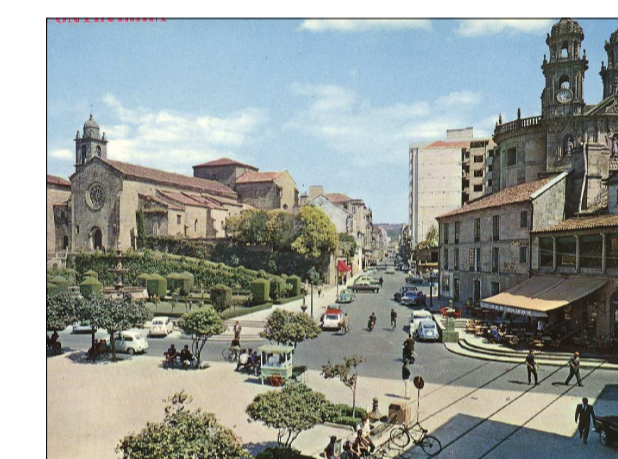
Vista da Colexiata da Peregrina dende a Praza da Ferrería_Ano 1967
