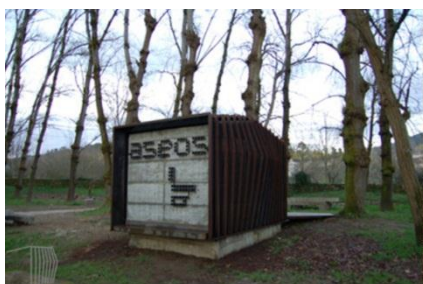
Fig.16: Vista general aseos
