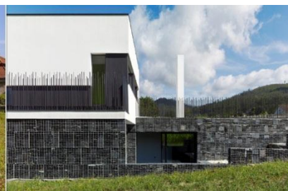
Fig. 5 Vista parcial vivienda
