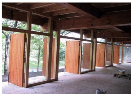
Fig.34: Construcción As Corcerizas
