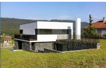
Fig.4 Vista general de la vivienda
