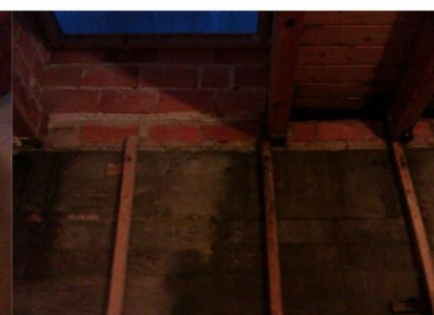
Fig.38: Humedad muros enterrados
