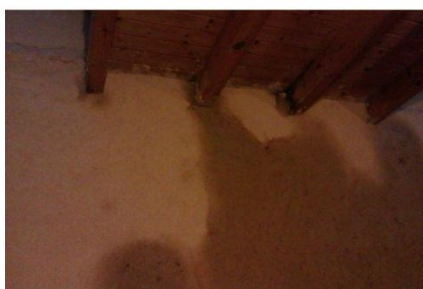
Fig.37: Humedad muros enterrados
