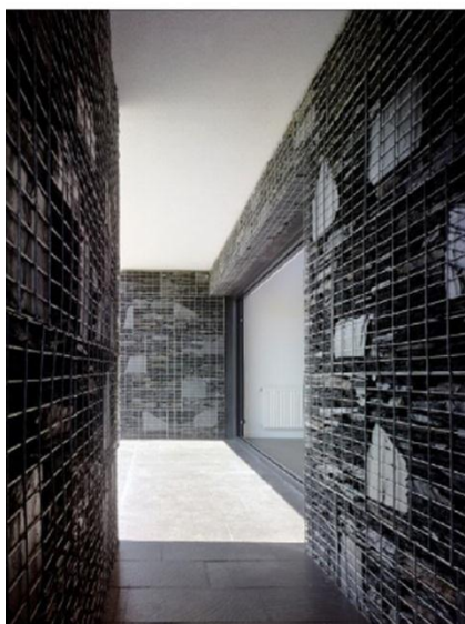
Fig. 6 Detalle gabiones pizarra
