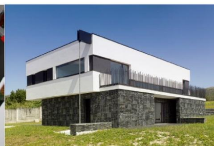
Fig.10 Vista general de la vivienda
