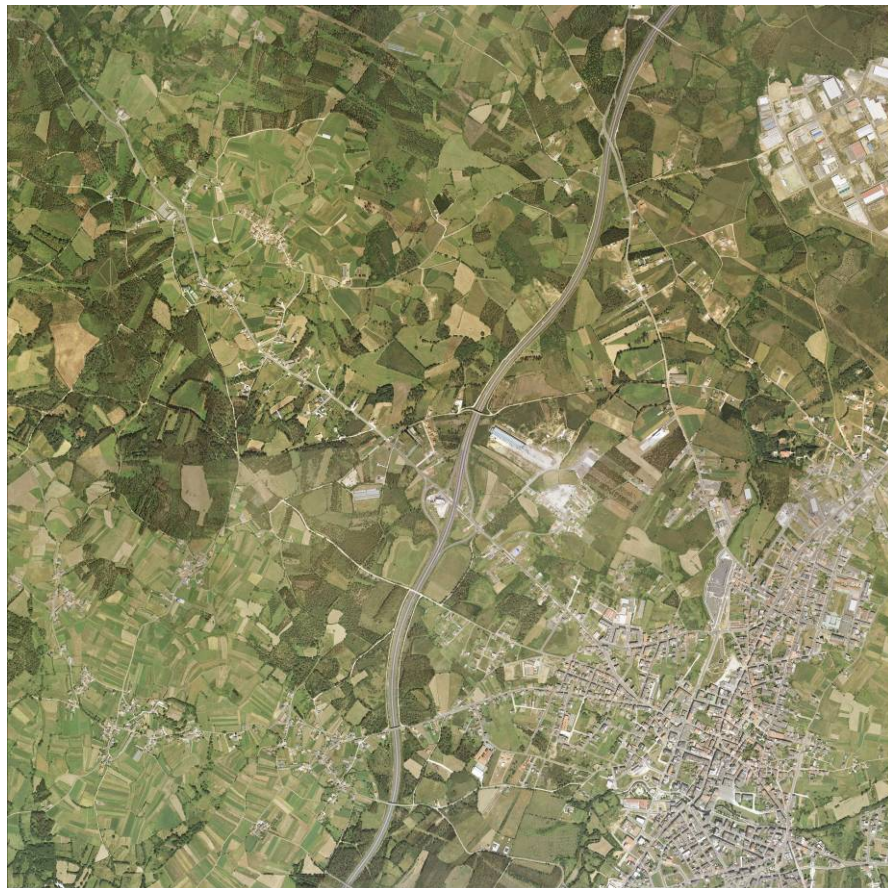
4.- Fotografía aérea de Carballo y entorno en 2006 (Fuente: Ign)
