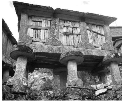
Fig. 45 Espigueiro misto, com estrutura assente em mós, Gavieira
