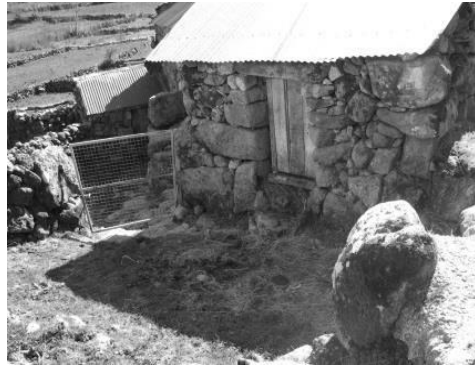
Fig. 67 Habitação com pátio, branda de Gorbelas.
