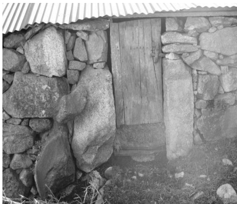
Fig. 11 Forma irregular não aparelhada; blocos de maior dimensão nas ombreiras
