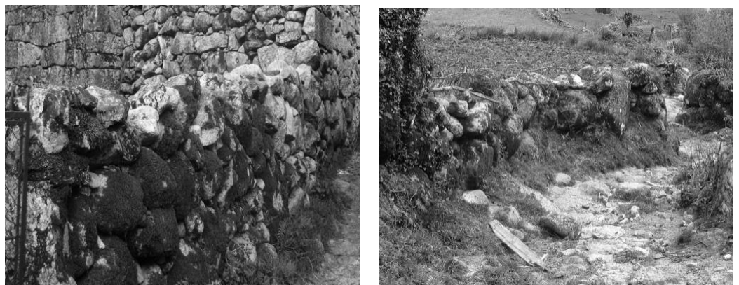
Fig. 22 e 23 Muro em pedra não aparelhada, Gavieira
