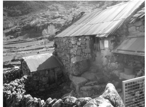
Fig. 68 Pátio com eira, corte e alpendre, branda de Gorbelas.
