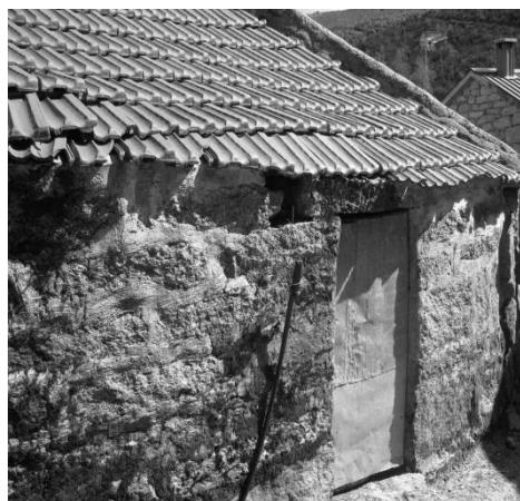
Fig. 16 Alvenaria de pedra irregular dispostas na horizontal com argamassa de cal
