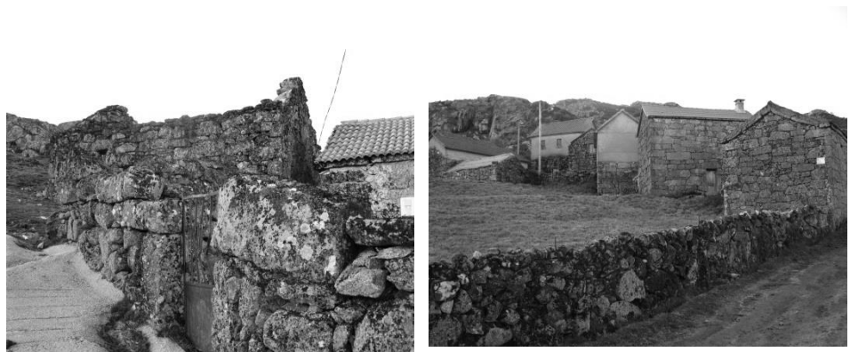
Fig. 29 Muro em pedra não aparelhada, Branda de Busgalinhas
