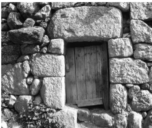
Fig. 24 Forma irregular não aparelhada; blocos de maior dimensão na padieira e ombreira
