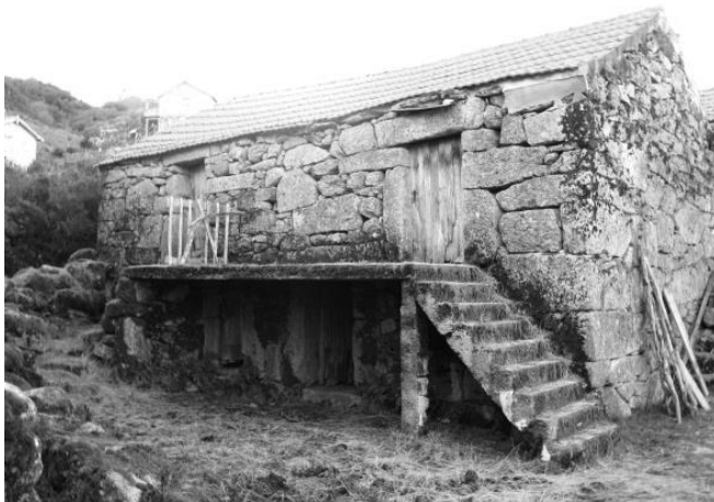
Fig. 30 Habitação com alvenaria em junta seca de pedras não aparelhadas
