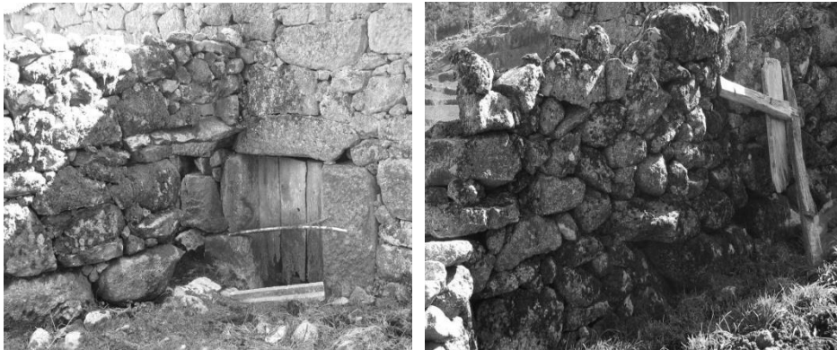
Fig. 9 e 10 Muro em pedra não aparelhada, Branda de Gorbelas.
