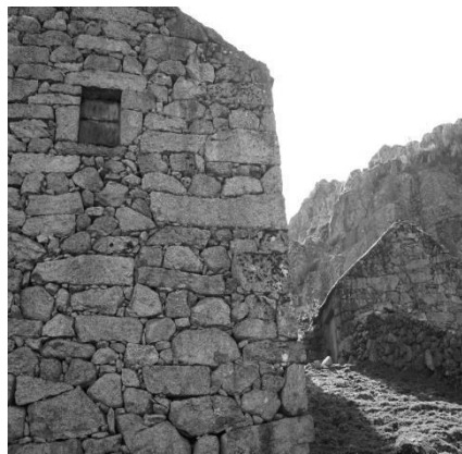
Fig. 12 Alvenaria de pedra com junta seca; cuidado no lintel
