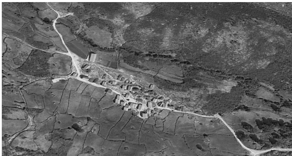
Fig. 17 Branda da Junqueira, vista aérea 2004
