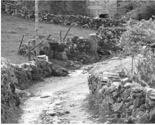
Fig. 2 Muro em pedra não aparelhada, Rouças
