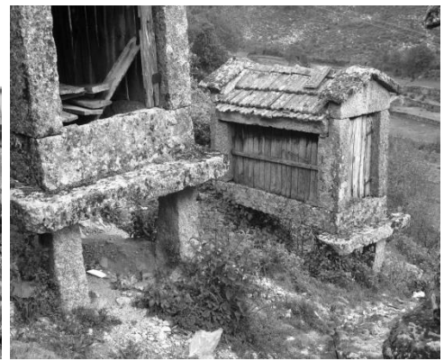
Fig. 46 Espigueiro misto, com estrutura assente em mesas; Guarda-ventos na cobertura, Gavieira
