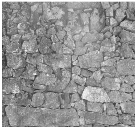
Fig. 14 Parede em junta seca com pedras irregulares e angulosas
