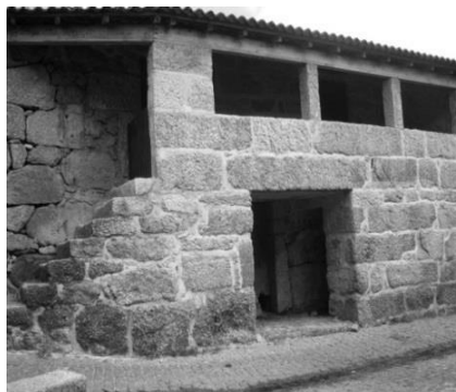
Fig. 7 Alvenaria de pedra com junta argamassada
