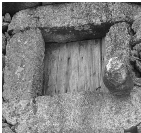
Fig. 41 Janela com portada, branda de Gorbelas
