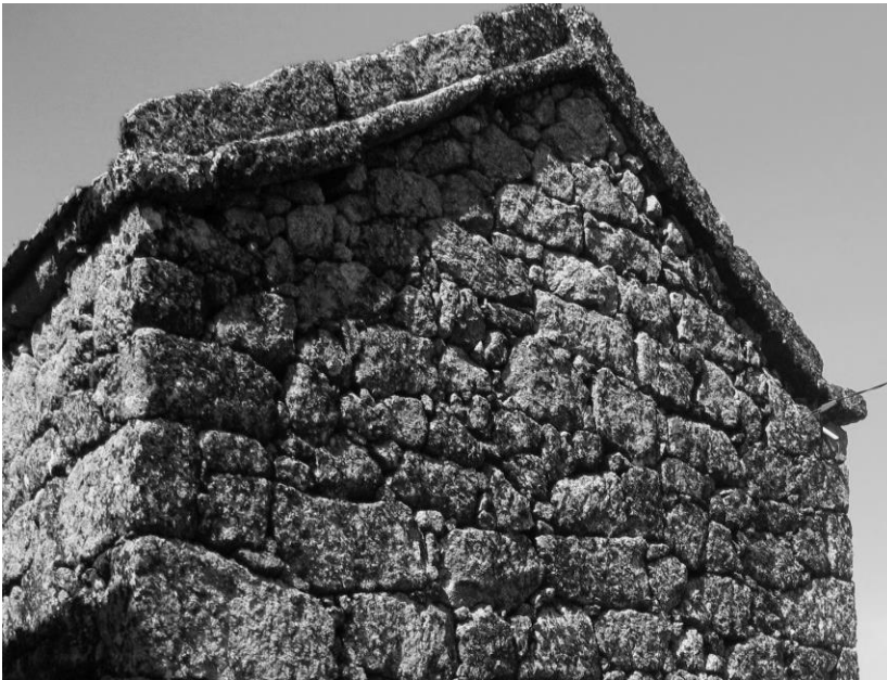
Fig. 32 Guarda ventos, branda Gorbelas, Rouças.
