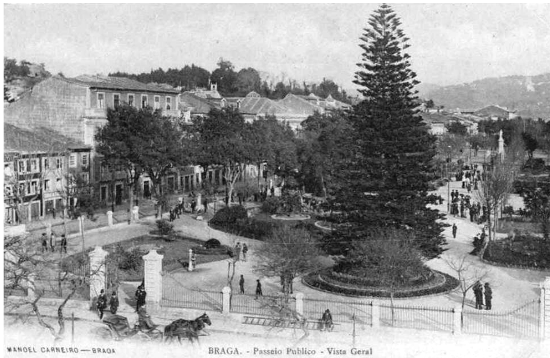
Fig. 62 - Desde la Arcada (a Oeste), vista del Passeio Público e Jardim (mediados del siglo XIX).
