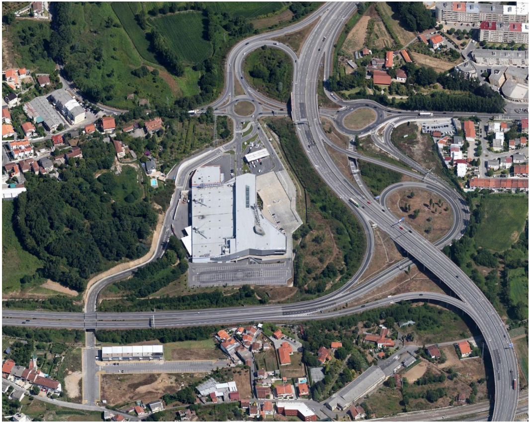
Fig. 138 - Superficie comercial próxima a un nudo viario en la periferia de Braga, a Suroeste.
