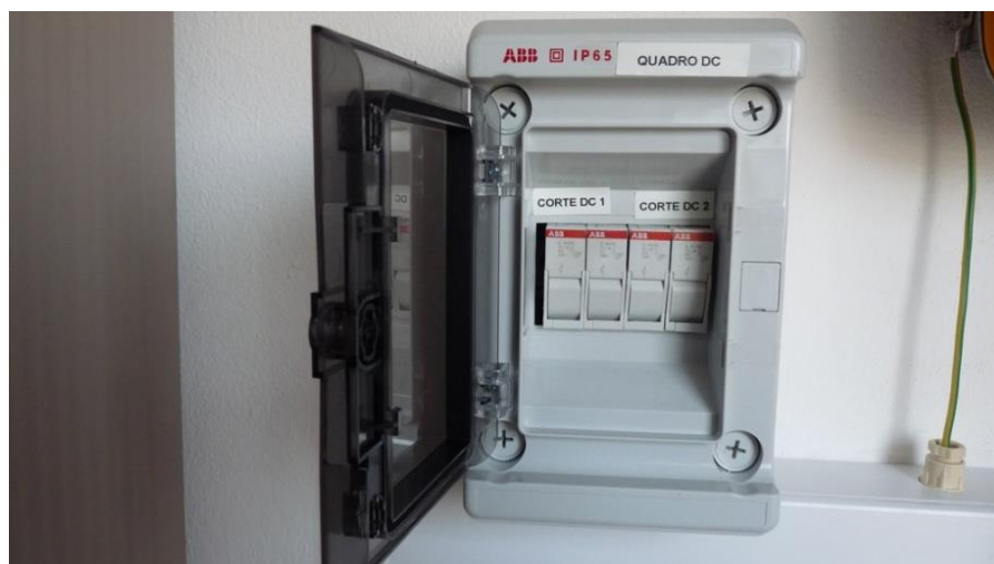
Figura 9 - Quadro AC do gerador fotovoltaico.
